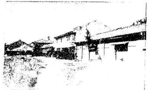
立命館日満高等工科学校実験室棟 (1940・41年頃)
